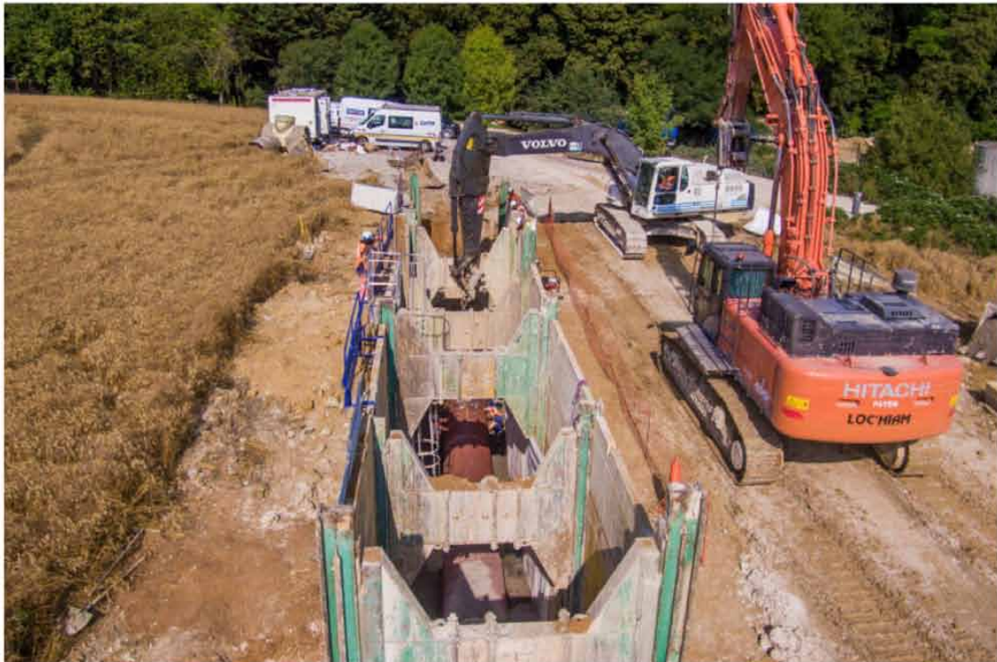
Sade Travaux Spéciaux a posé 9,4 kilomètres de canalisation à ciel ouvert et par microtunneliers dans le nord de la Seine-et-Marne. ©Sade
