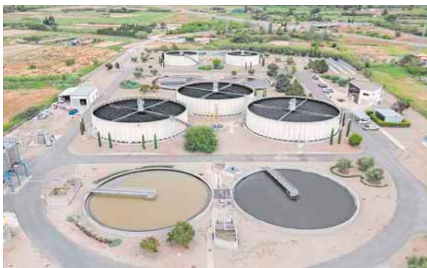
Imagen aérea de la depuradora de aguas residuales de Nilsa en Tudela.
