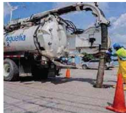
La empresa adelanta limpieza de tuberías y colectores.
