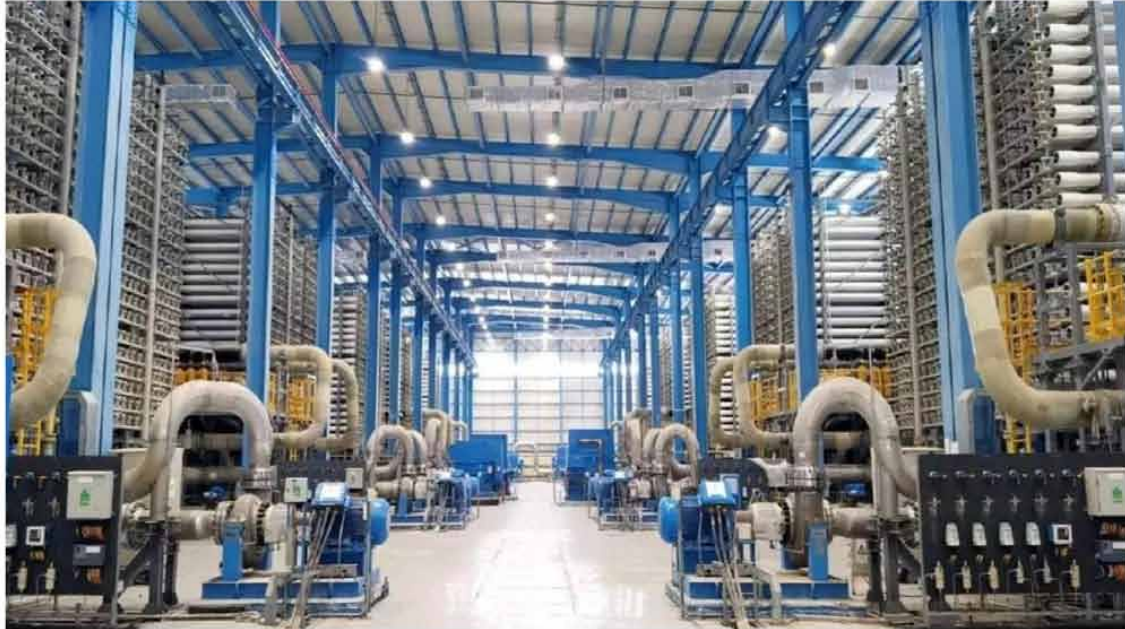
Una de las últimas desaladoras que ha puesto en marcha Coxabengoa. / INFORMACIÓN
